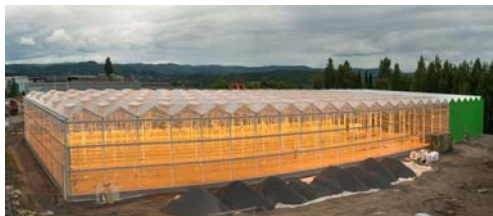
Odlingsanläggningen under uppbyggnad hösten 2017
